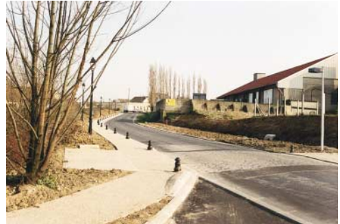
Sites après aménagement en béton désactivé
